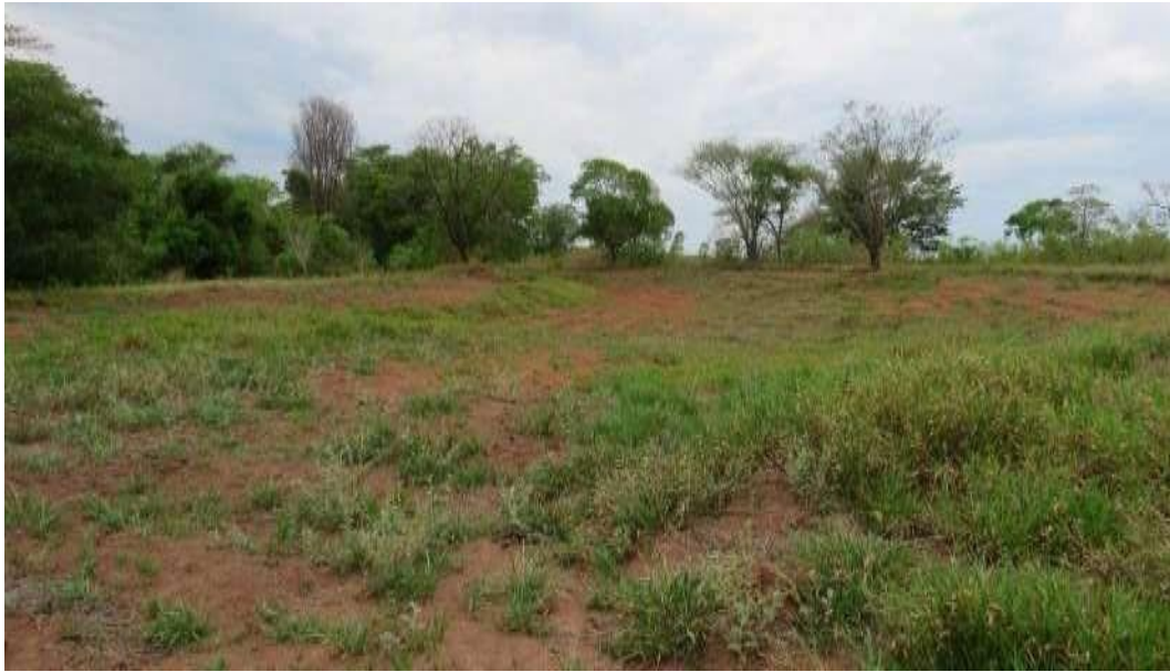
Figura 15 - Imagem aérea da área à jusante do barramento (área ampliada do canteiro). Janeiro de 2020.
