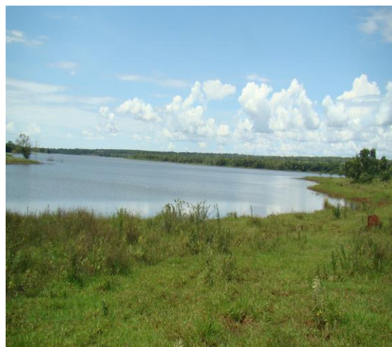
Foto - 2. Vista geral da margem direita bem estabilizada na região da AM3, acima do PE3.
