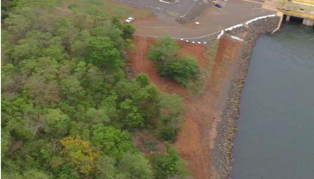
Figura 11 – Imagem aérea da área próxima à casa de força e subestação. Janeiro de 2020.
