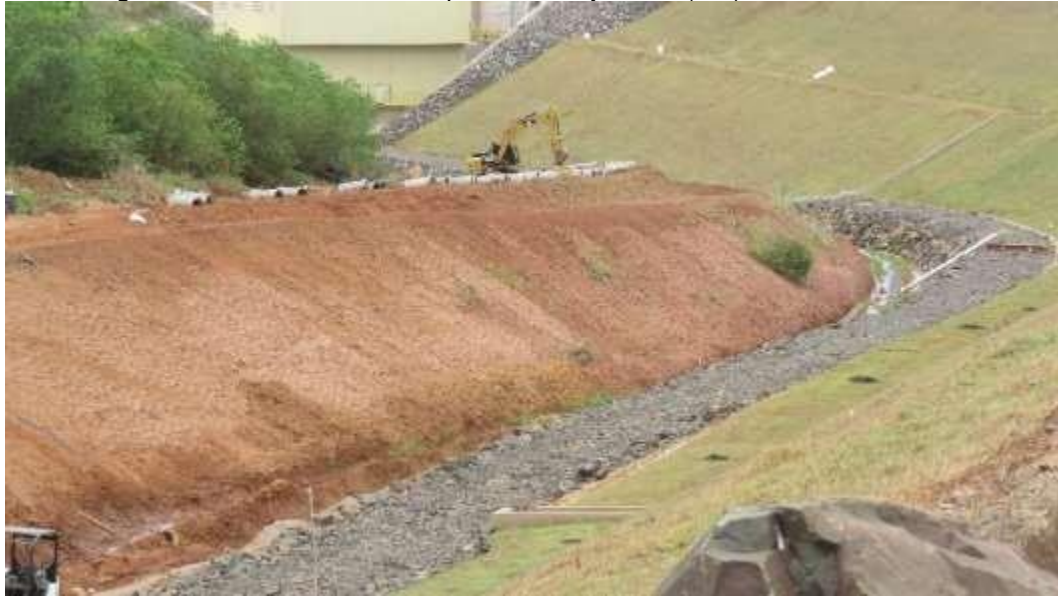
Figura 17 - Imagem aérea da Área Acesso provisório à jusante (ME). Janeiro de 2020.
