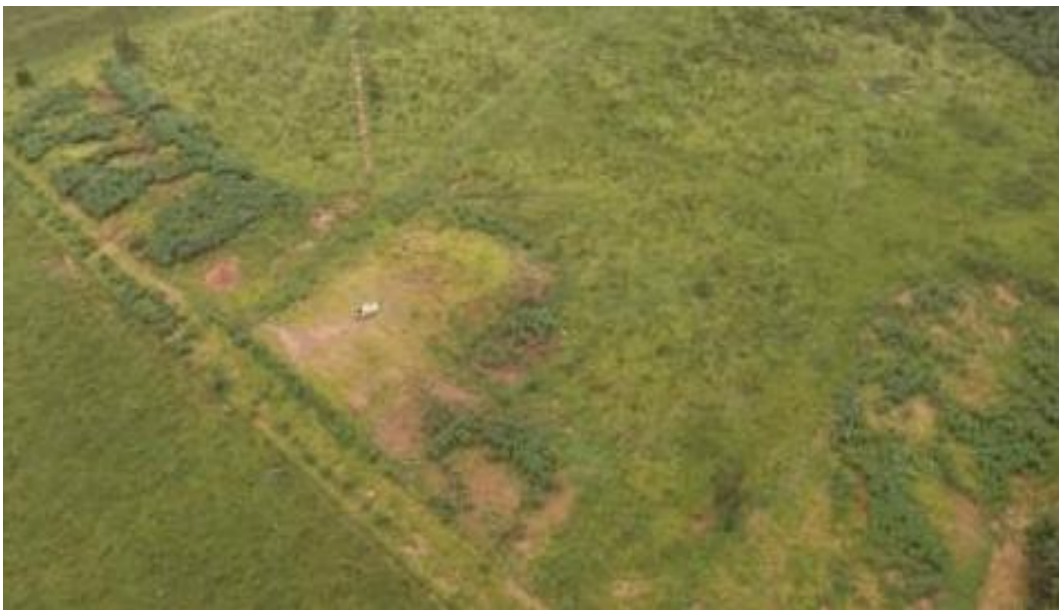
Figura 2 - Imagem aérea da área do antigo escritórios e área de vivência já desmobilizada. Junho de 2020.
