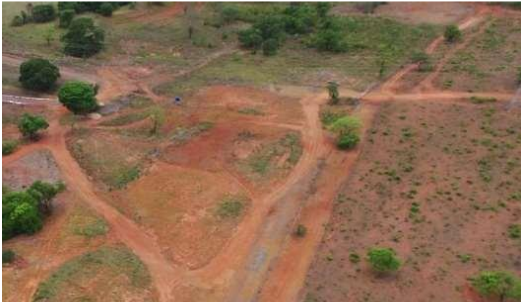
Figura 7 – Imagem aérea da área anteriormente ocupada por: Armação, Central de Carpintaria, Almoxarifado Civil e Eletrotécnica. Janeiro de 2020.
