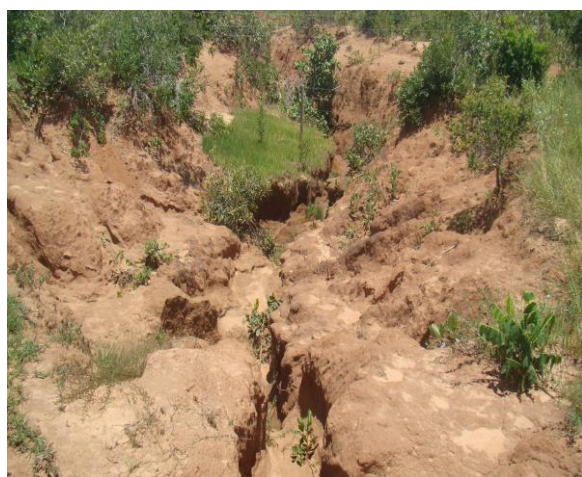
Foto - 7. Vista interna do processo erosivo PE3 no ponto da cerca da divisa com a APP.
