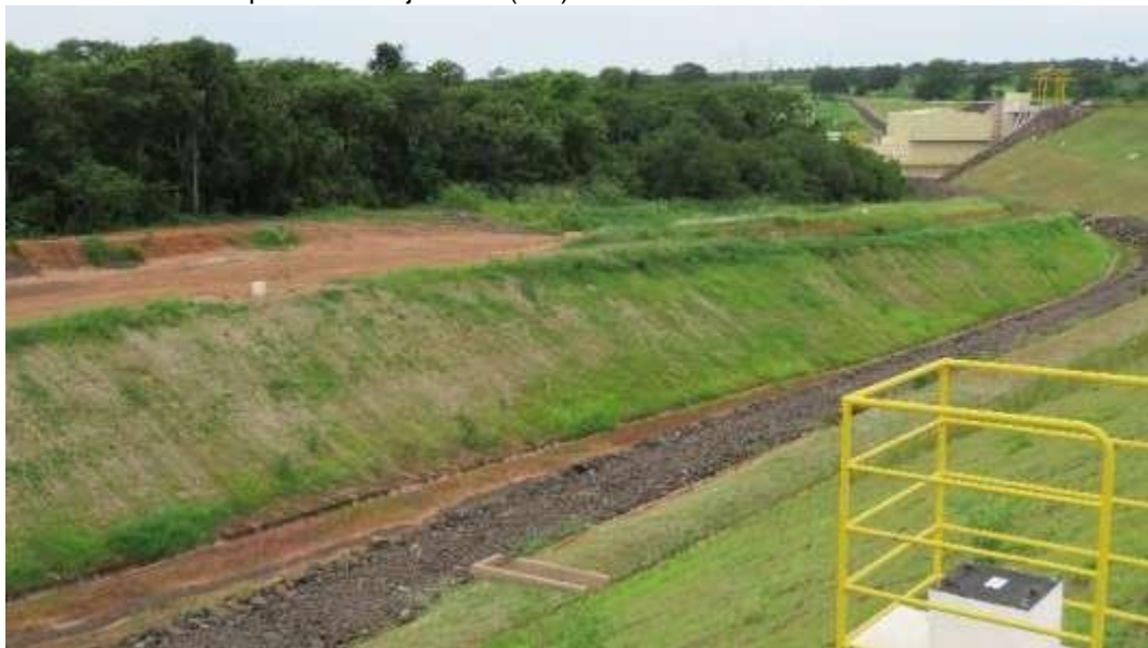
Figura 18 - Área Acesso provisório à jusante (ME). Junho de 2020
