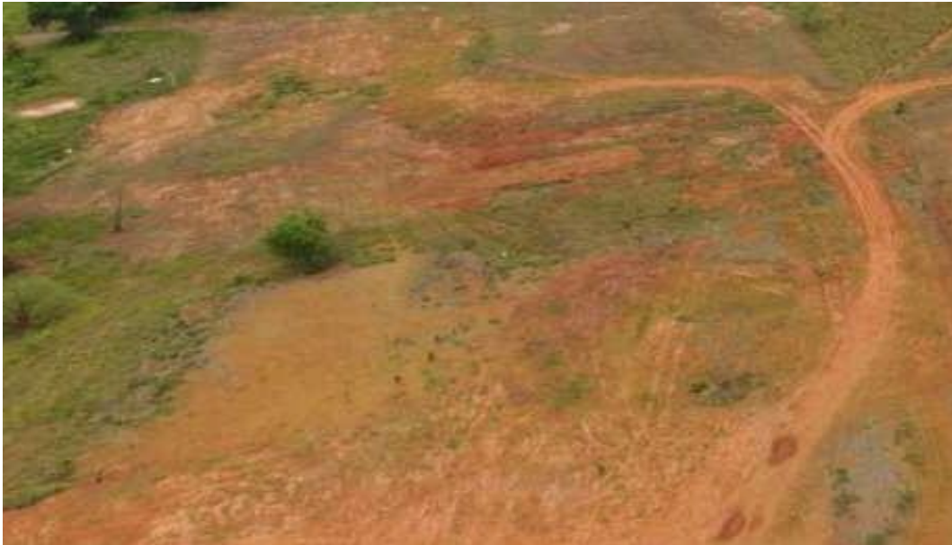
Figura 5 – Imagem aérea da área antigamente ocupada pelas estruturas da rampa de lavagem e oficina e posto de combustível. Janeiro de 2020.
