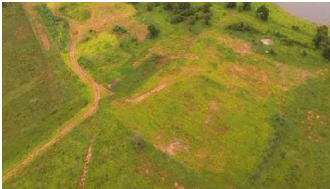
Figura 6 – Imagem aérea da área antigamente ocupada pelas estruturas da rampa de lavagem e oficina e posto de combustível. Junho de 2020.
